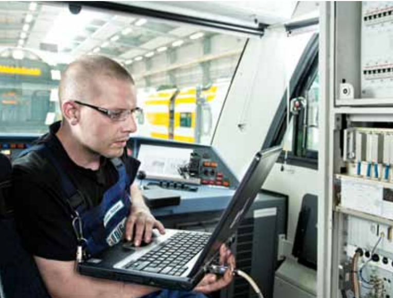
Instandhaltung: Check der punktförmigen Zugbeeinflussung (PZB) durch ODIG-Mitarbeiter Torsten Grüneberg.
