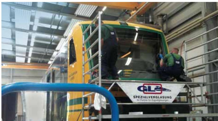
Präzision und Schnelligkeit: GL Spezialverglasung setzt eine neue Frontscheibe in RegioShuttle ein.
